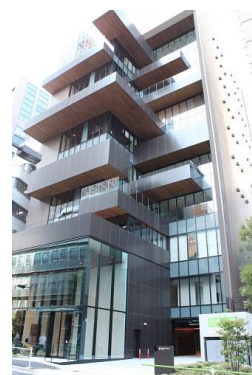
プライムテラス神谷町(外観)
